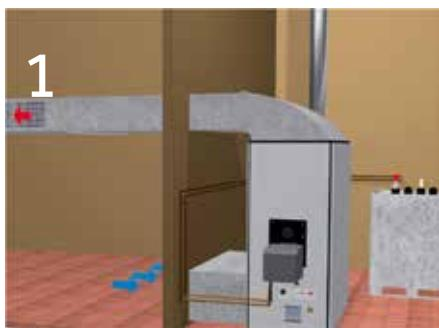
Generador de aire caliente con impulsión de aire mediante red de conductos y aspiración del local adyacente.
