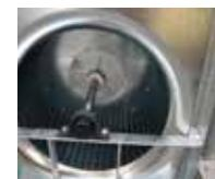
Grupo ventilador en acero galvanizado (con bastidor galvanizado en caliente) con tapas de protección del eje del ventilador.
